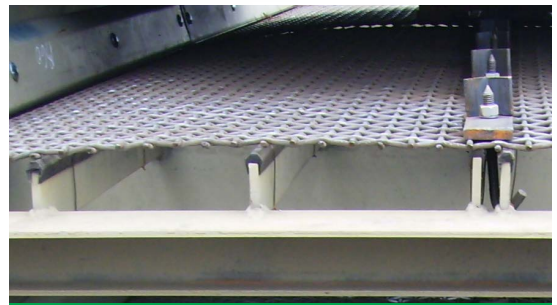
Aplicación de los burletes en zaranda.
